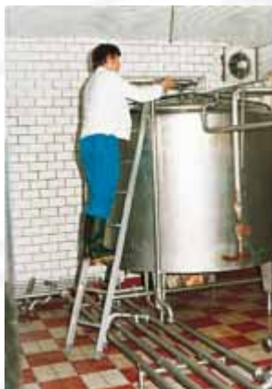
Bild 31: Leiter mit Einhängvorrichtung am Behälter
