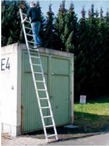
Bild 40: Übersteigen von der Anlegeleiter
